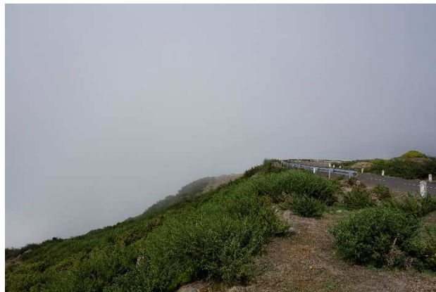
Fotografia 4.12 – Zona de desenvolvimento da conduta forçada/elevatória paralela a ER110 e da Levada do Paul II
