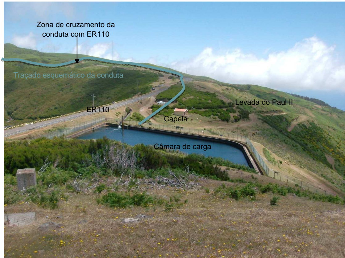
Fotografia 4.8 – Vista panorâmica do traçado e zona envolvente da conduta forçada/elevatória
