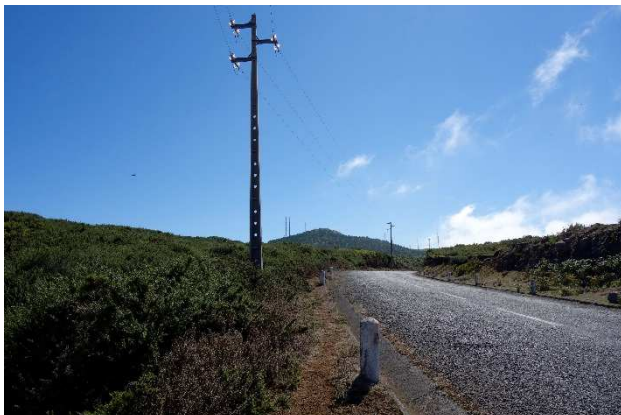
Fotografia 4.11 – Zona de cruzamento da conduta forçada/elevatória com a ER110
