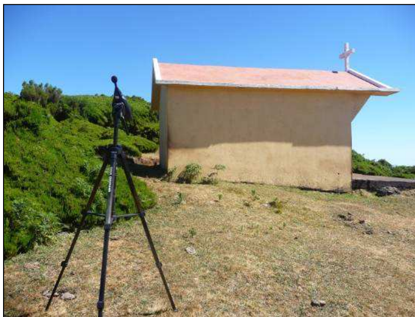
Fotografia 4.15 - Zona Ponto P3 – Capela junto à atual câmara de carga do Paul
