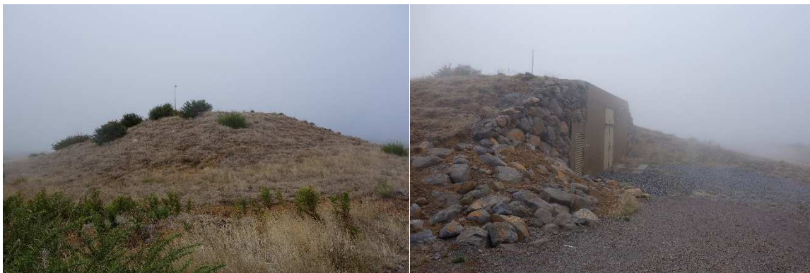
Fotografia 5.1 – Vista sobre a integração do posto de corte na envolvente
