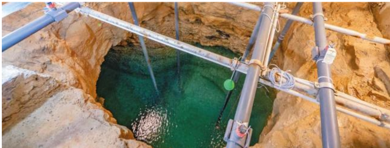
Figura – Central Dessalinizadora Porto Santo [Fonte: ARM]
