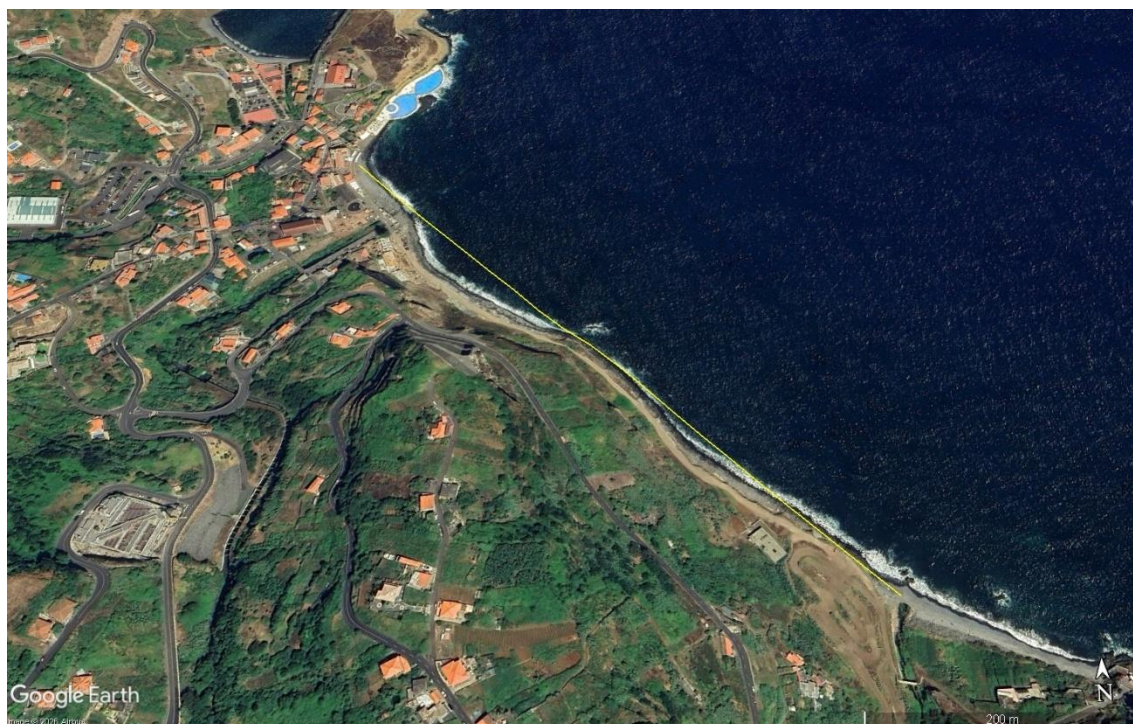
Figura 16 – Frente Mar entre a Ribeira da Maiata e as Piscinas do Porto da Cruz
