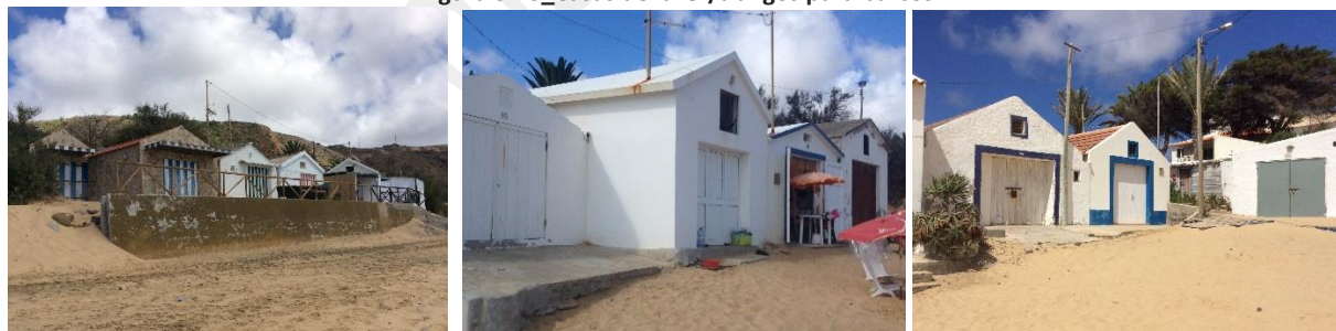
Figura 3.20_ Casas de lazer/abrigos para barcos
