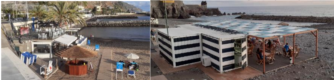
Figura 3.20_ Equipamentos de apoio – estabelecimentos comerciais com funções de apoio de praia
