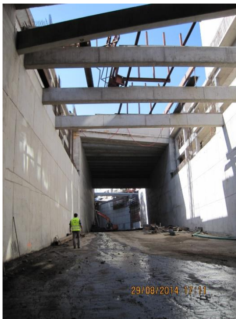
Figura 43 - Ribeira de S. João. Exemplo de intervenção após o evento de 20 de fevereiro de 2010.
