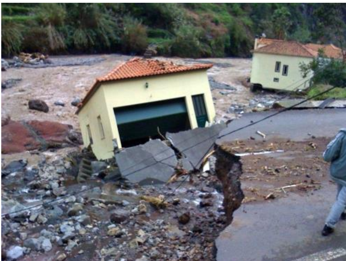
Figura 4 - Moradias e estrada danificadas pela aluvião (Meia Légua).
