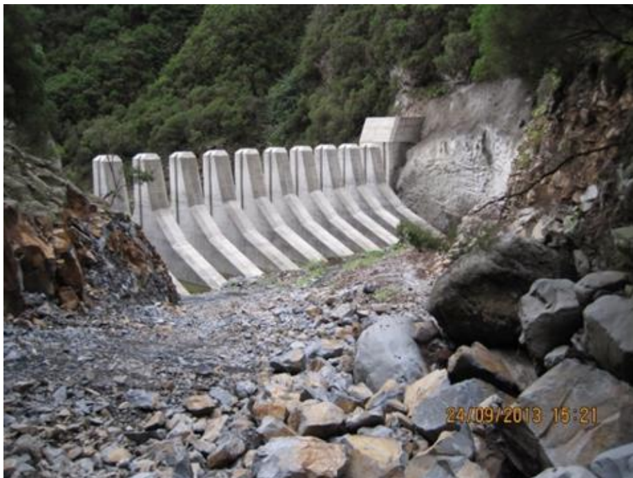
Figura 42 - Exemplo de medida estrutural. Estrutura de retenção construída na ribeira de Santa Luzia (2013).
