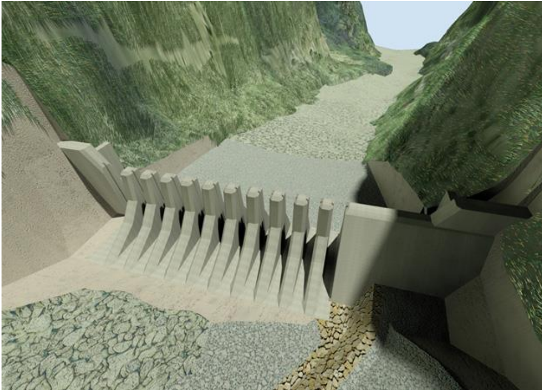
Figura 41 - Exemplo de medida estrutural. Antecipação computacional de uma estrutura de retenção de material sólido (empresa LCW).
