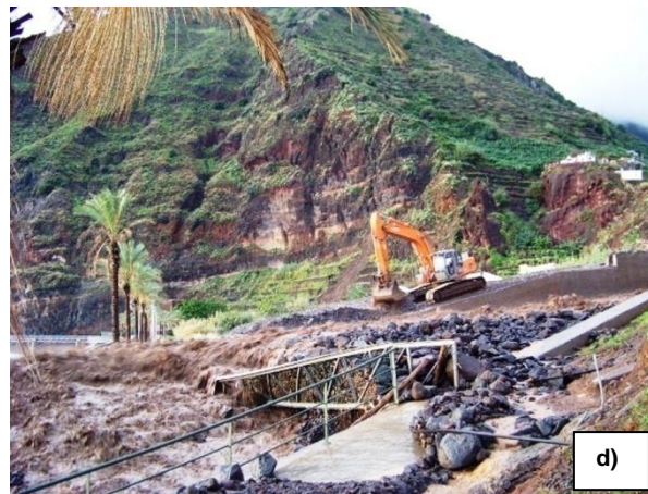
Fotografia 7.1 - Ponte Pedonal sobre a foz da ribeira da Madalena do Mar: a) e b) Antes e após a cheia de Fevereiro de 2010, respectivamente; c) e d) Antes e após a cheia de Outubro de 2010, respectivamente.
