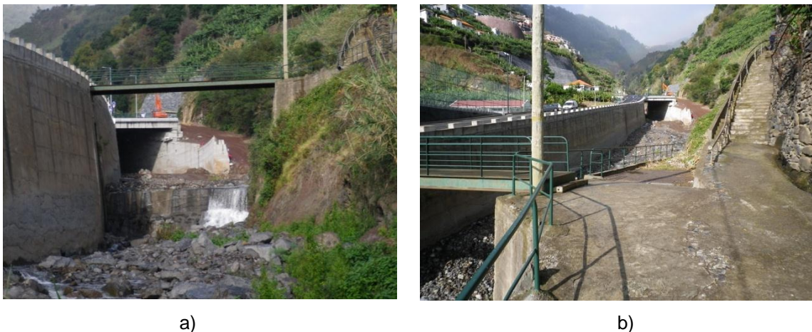
Figura 7.8 – Ponte RMM5: a) Vista geral. b) Encontro esquerdo.
