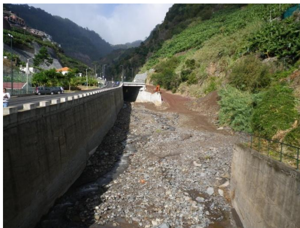
Fotografia 7.3 – Zona de construção do muro do lado esquerdo.
