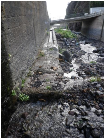
Fotografia 7.7 – Levada a repor na margem esquerda, localizada a montante da ponte RMM4.
