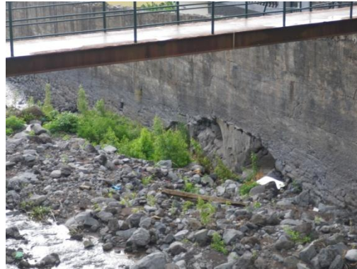
Fotografia 6.10 – Zonas onde o muro se encontra parcialmente destruído
