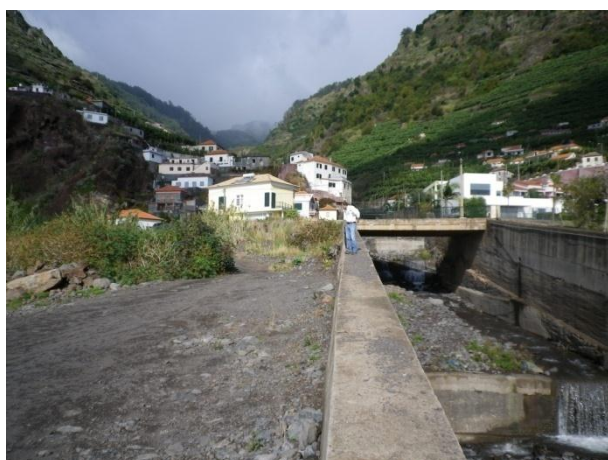
Fotografia 7.4 – Zonas onde se prevê a demolição e reconstrução das muralhas existentes.
