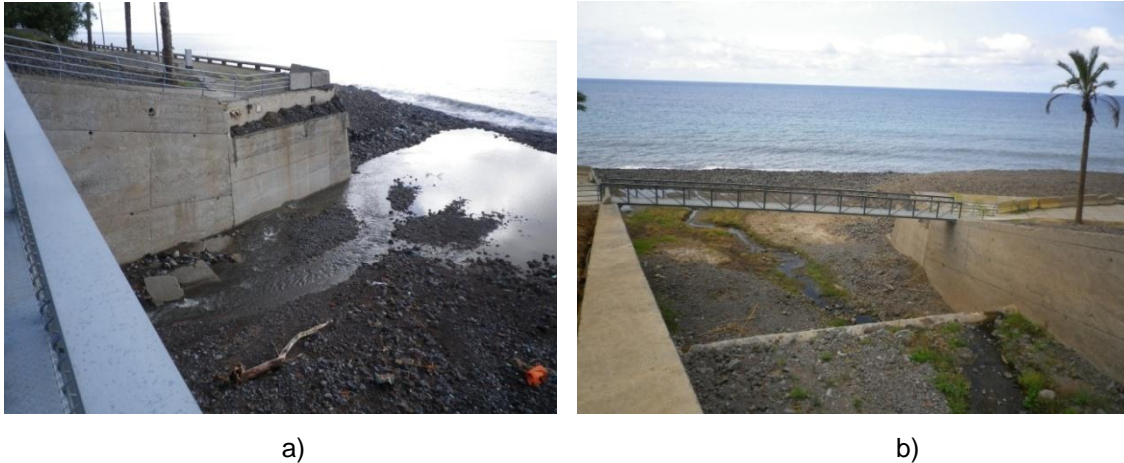
Figura 7.4 – Ponte RMM1: a) Localização da ponte pedonal. b) Vista de montante com o passadiço a desactivar.
