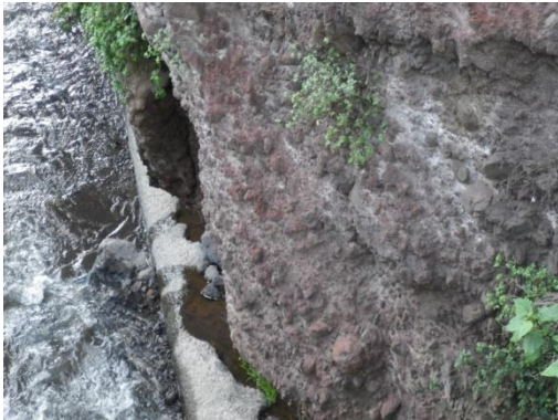
Fotografia 6.10 – Zonas onde o muro se encontra parcialmente destruído
