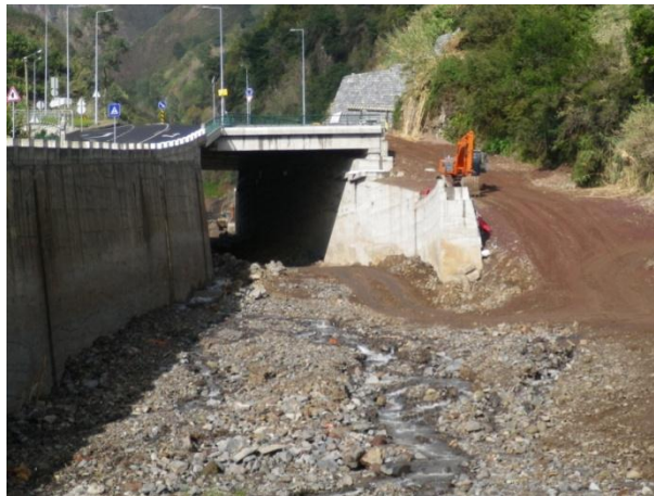
Fotografia 7.6 – Localização da rampa de acesso à ribeira na margem esquerda (vista de jusante para montante).
