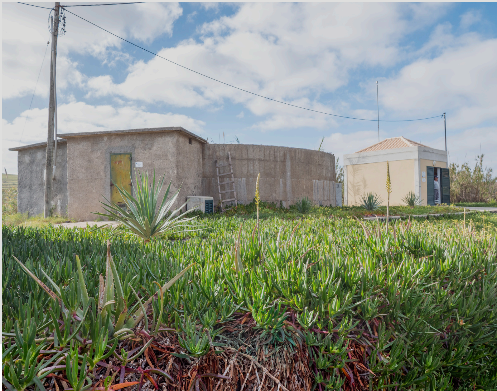
Reservatório de Rega Porto Santo
