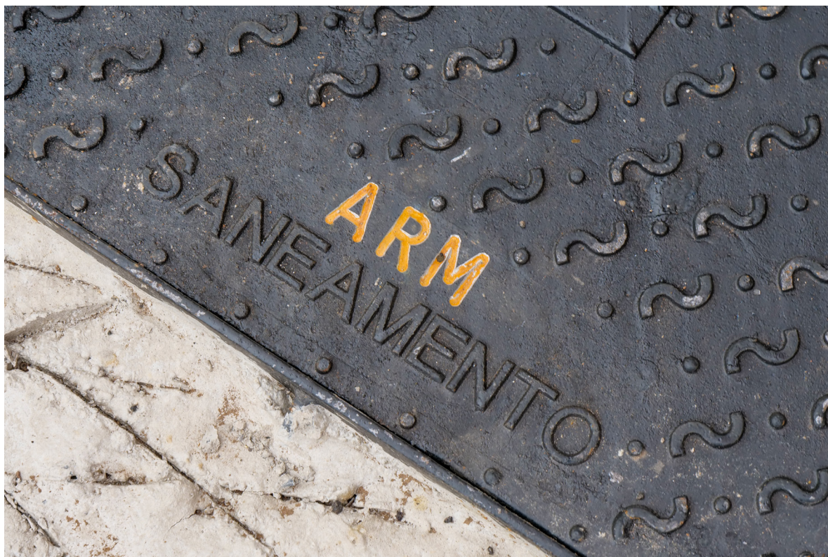
Obra de Saneamento no Garachico
