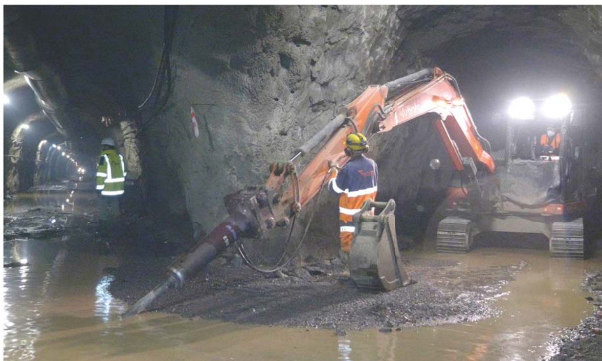
Obra do Túnel do Pedregal
