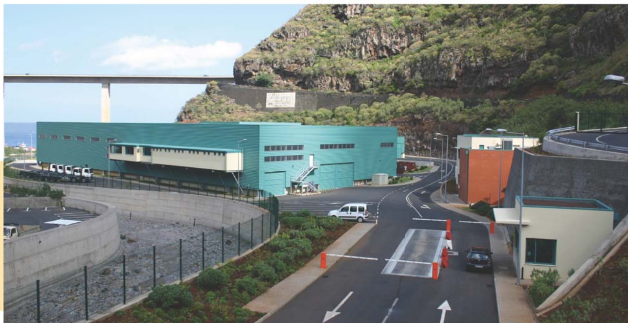
Edifício de Triagem da ETZL/ET
