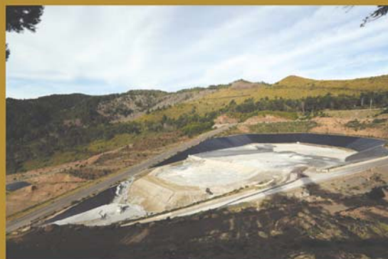
Aterro em operação, ETRS da Meia Serra
