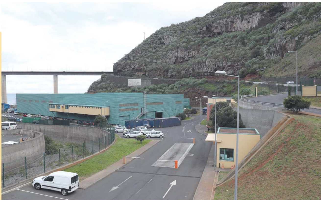
Estação de Transferência da Zona Leste
