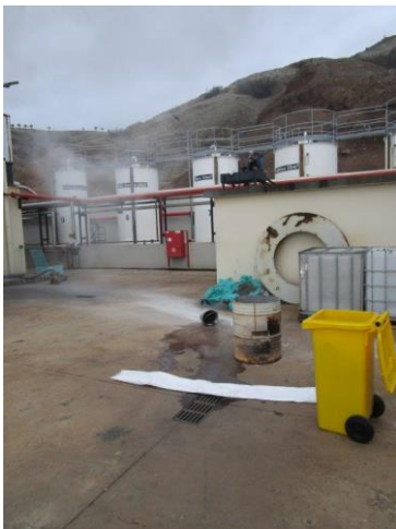
Contenção do derrame
