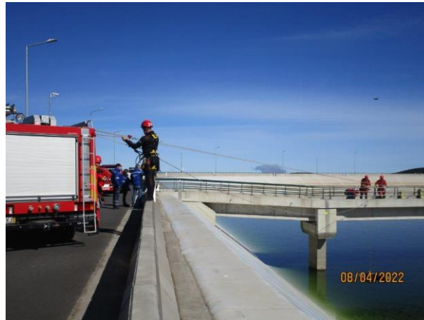
Montagem da tirolesa pela equipa de resgate em montanha
