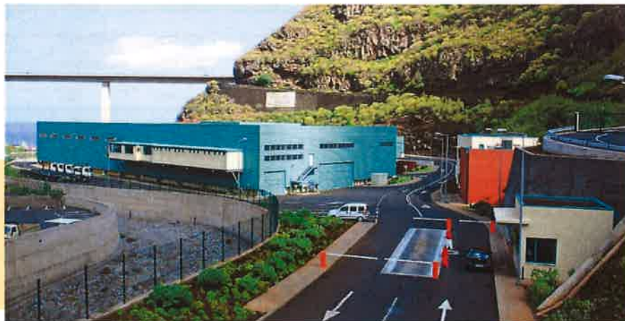
Edifício de Triagem da ETZL/ET
