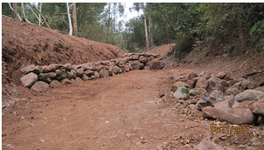
Criação de faixa natural de assoreamento
