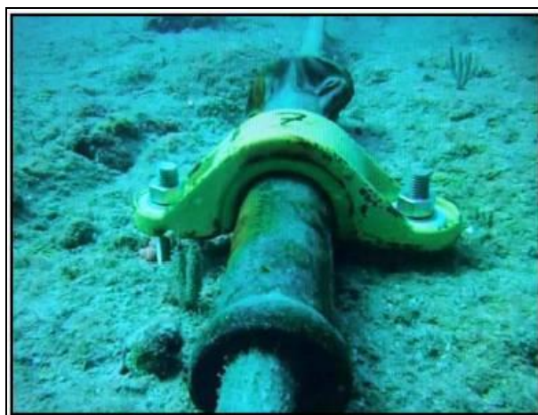
Figura 15: Exemplo de instalação da braçadeira tipo sela (âncora com dois parafusos).
