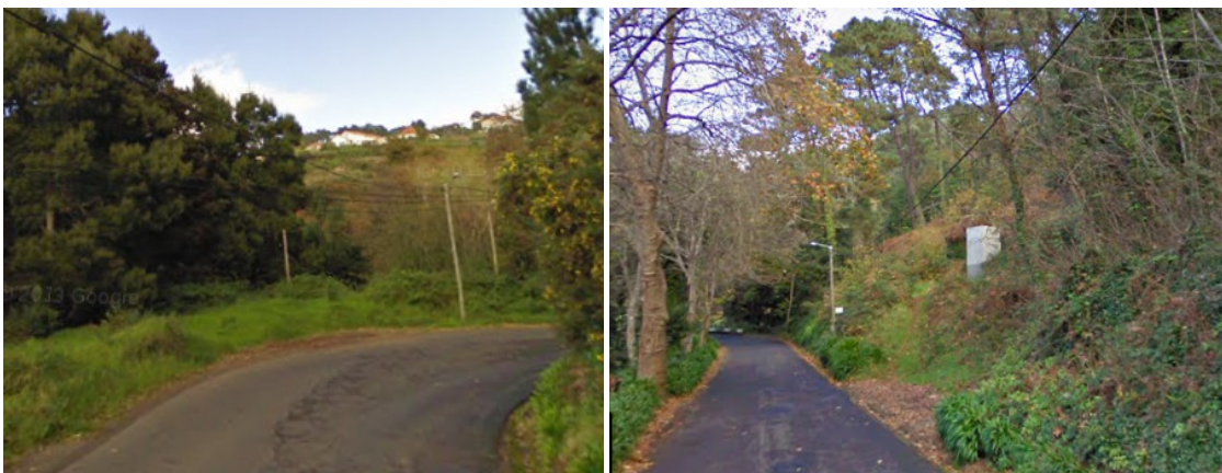
FIGURA 4.2 – TROÇOS DA ATUAL ER 222 ENTRE RAPOSEIRA E FAJÃ DA OVELHA
