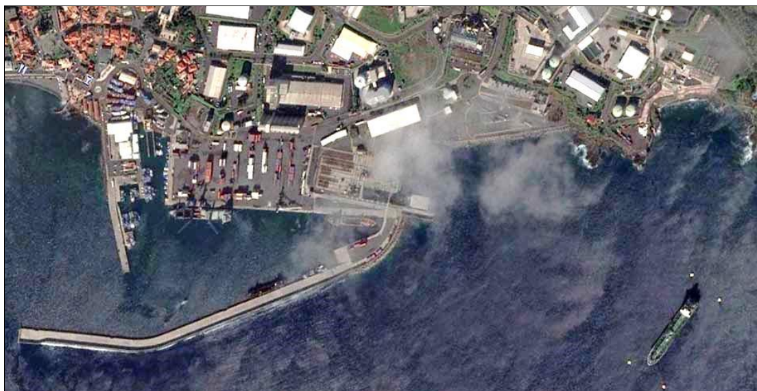
FIGURA 6.29 – PORTO DO CANIÇAL E TERMINAL MARÍTIMO ESPECIALIZADO PARA DESCARGA DE COMBUSTÍVEIS (A NASCENTE) COM NAVIO-TANQUE POSICIONADO
