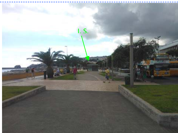
Passeio marítimo e acessos às Instalações Sanitárias Públicas
