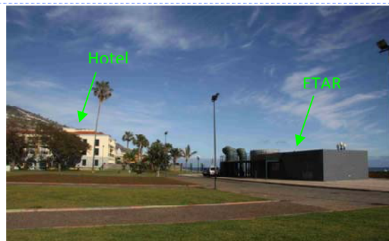
Hotel Porto Santa Maria (a nascente da ETAR)
